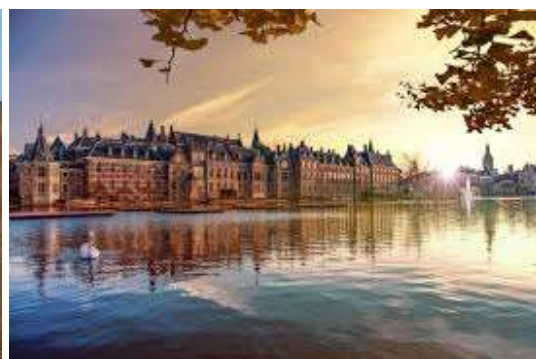
Regierungszentrum Den Haag
